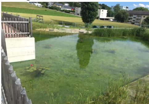
Abbildung 2: Aufbereitungsbereich im Naturpool in Beringen
