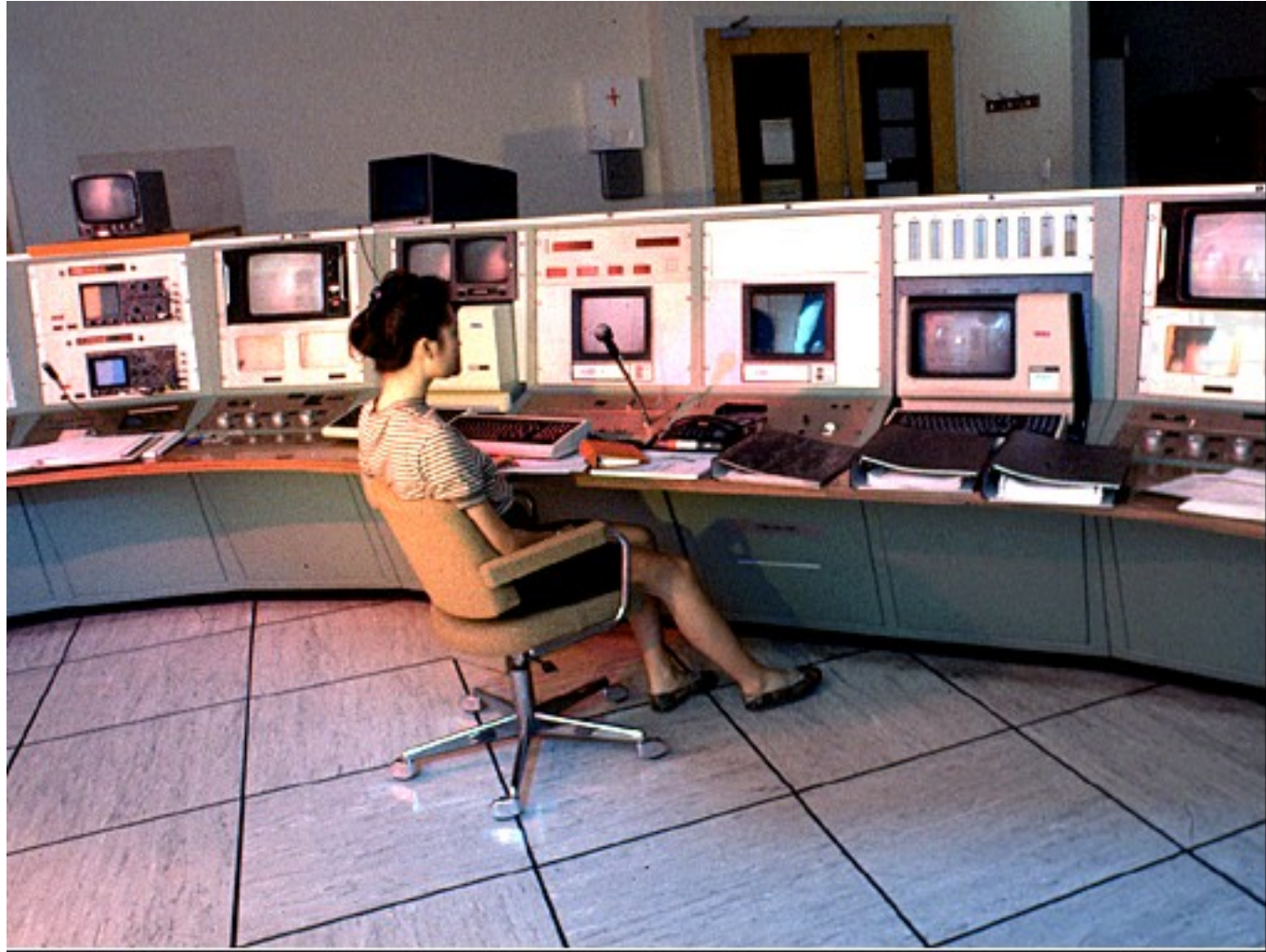
ZURÜCK In solchen Kontrollräumen werden die Teilchenbeschleuniger gesteuert. WEITER
